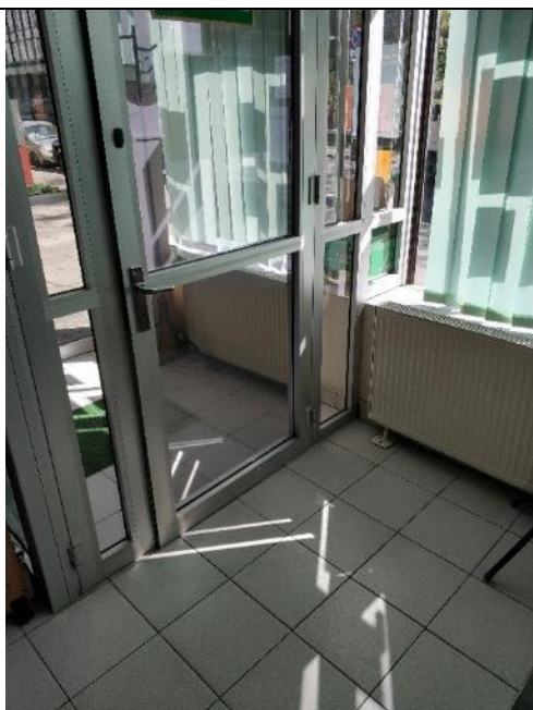
Il. 5. Zabudowa wiatrołapu przeznaczona do demontażu. Nad wejściem głównym projektuje się
